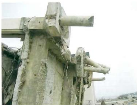
写真-2 前面側基礎の杭5本の状況 (2011.5.20撮影)
